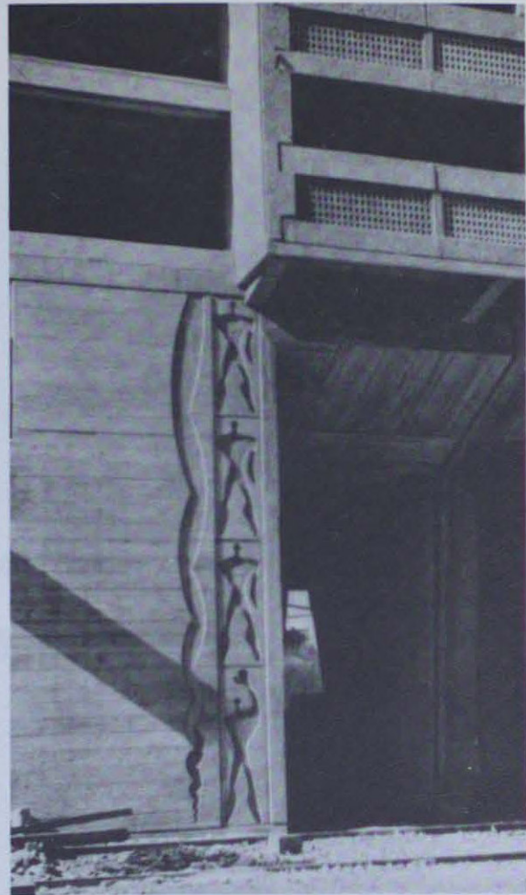
Detail of Unité d'habitation
